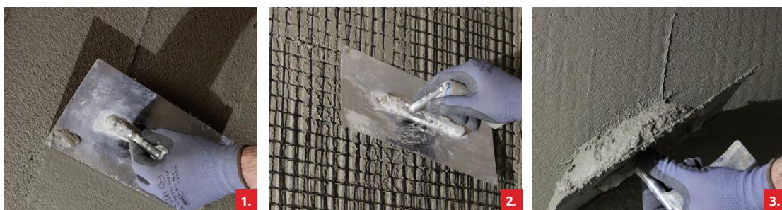
Ojačanje **SAMOBORKA FRCM** sustavom primjenjuje se, ovisno o projektu, jednostrano ili obostrano uz izvedbu poprečnog sidrenja kojim se onemogućava „odvajanje“ i povećava staticka učinkovitost primijenjenog sustava.
